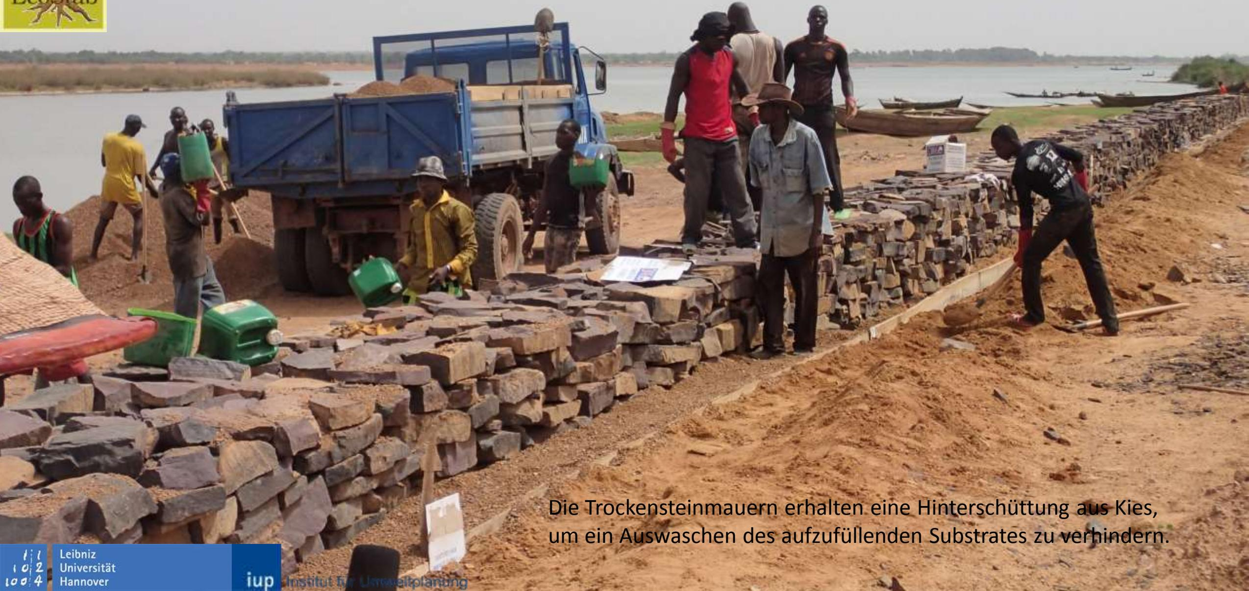
Die Trockensteinmauern erhalten eine Hinterschüttung aus Kies, um ein Auswaschen des aufzufüllenden Substrates zu verhindern.
