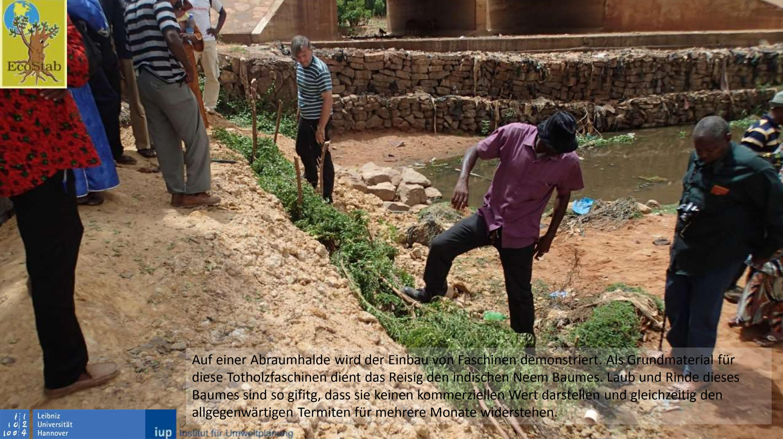
Auf einer Abraumhalde wird der Einbau von Faschinen demonstriert. Als Grundmaterial für diese Totholzfaschinen dient das Reisig den indischen Neem Baumes. Laub und Rinde dieses Baumes sind so giftig, dass sie keinen kommerziellen Wert darstellen und gleichzeitig den allgegenwärtigen Termiten für mehrere Monate widerstehen.
